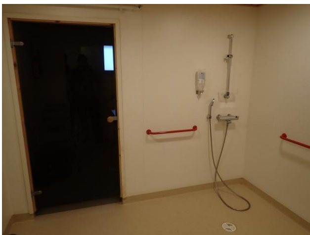
Yleiskuva saunatilan pesuhuoneesta.
