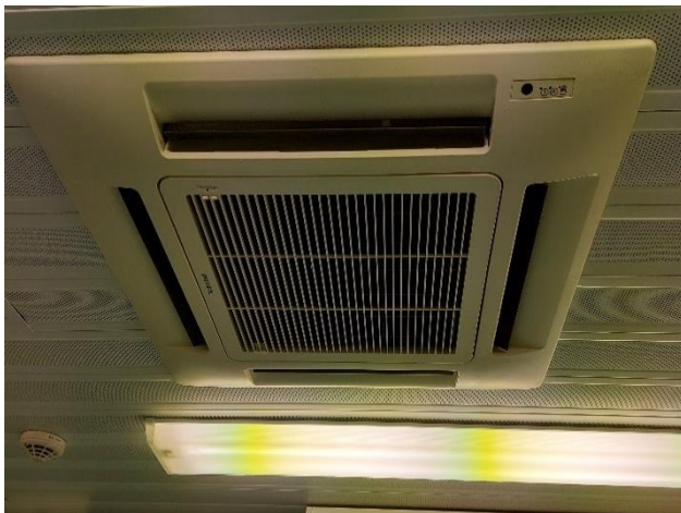
Yleiskuva puhallinkonvektorista.
