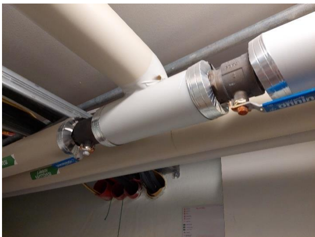
Yleiskuvia käyttövesiverkoston asennuksista ja sulkuventtiileistä.
