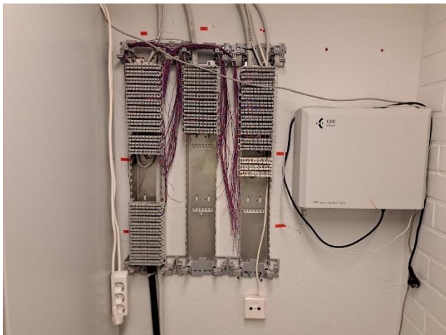
Puhelinkytkentärimat.
