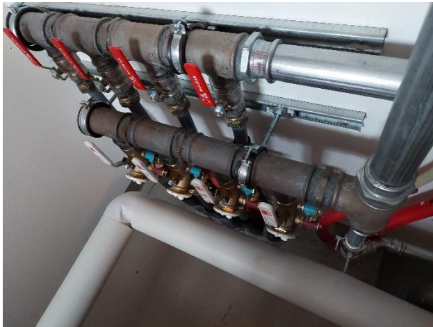
Yleiskuvat lämpöjohtoverkoston asennuksista, sulku- sekä linjasäätöventtiileistä ja lattialämmityksen jakotukista.
