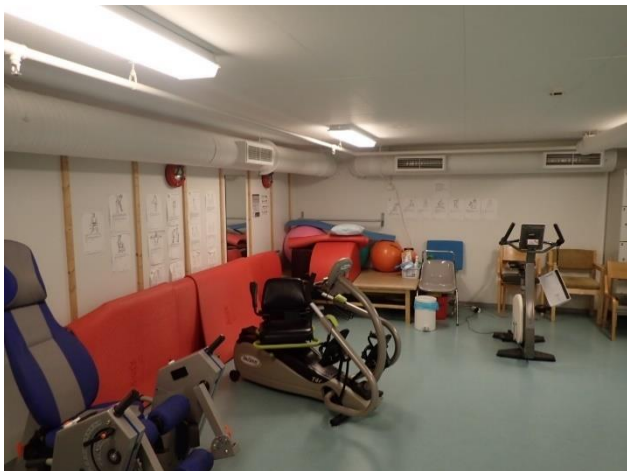
Yleiskuva väestönsuojasta ja väestösuojalaitteista.
