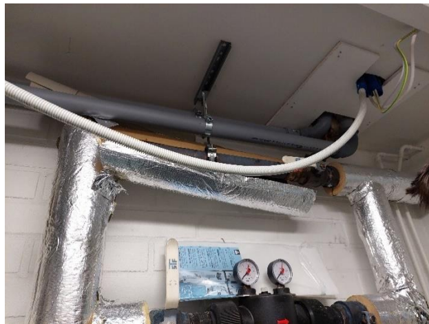
Sprinklerikeskuksessa irronnut putkieriste.
