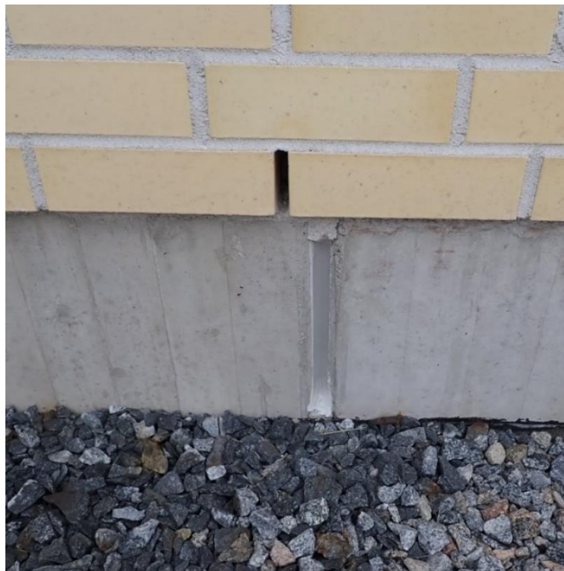
Elastisissa saumoissa ei havaittu puutteita.
