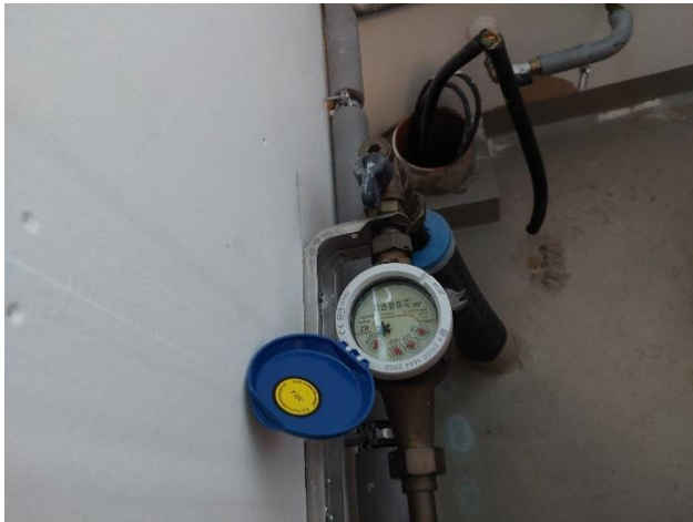
Kiinteistön päävesimittari
