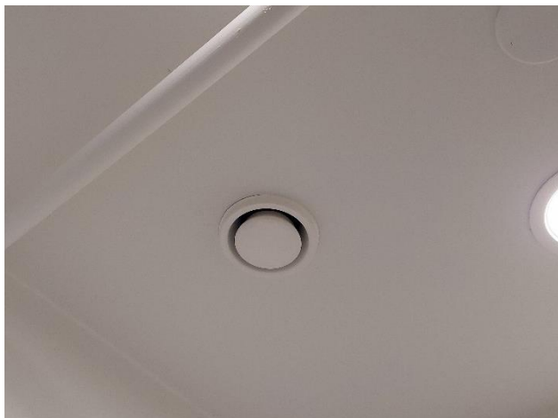
Yleiskuva poistoilmaventtiilistä.
