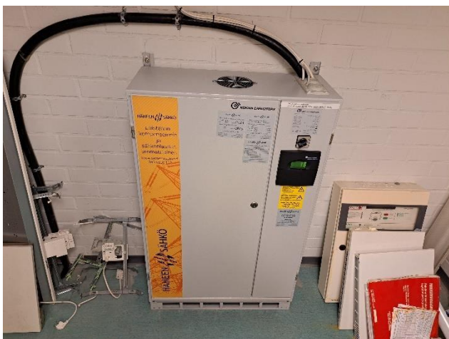
Loistehonkompensointilaitteisto.
