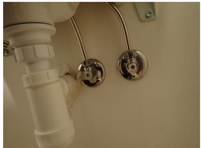
Käyttövesiputket ja pesualtaan viemärointi ovat seinärakenteen sisällä.
