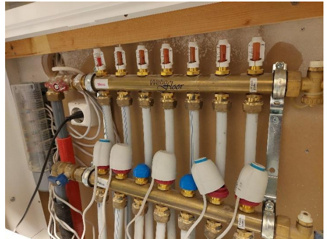
Yleiskuvat lämpöjohtoverkoston asennuksista, sulku- sekä linjasäätöventtiileistä ja lattialämmityksen jakotukista.
