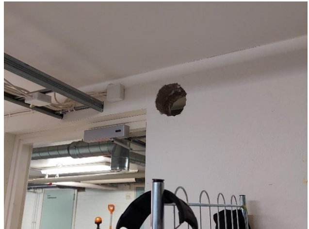
Varatila 0.015 puuttuva ilmanvaihtokanava/-venttiili.
