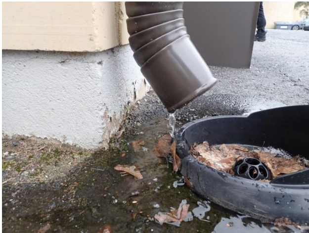
Sadevedet eivät ohjaannu rännikaivoon sprinklerikeskuksen nurkalla
