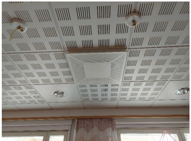
Varatila 0.015 puuttuva ilmanvaihtokanava/-venttiili.
